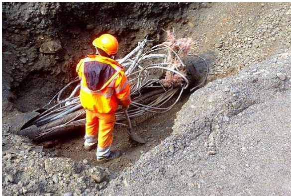
Abbildung 1 Leitungsschaden 2
